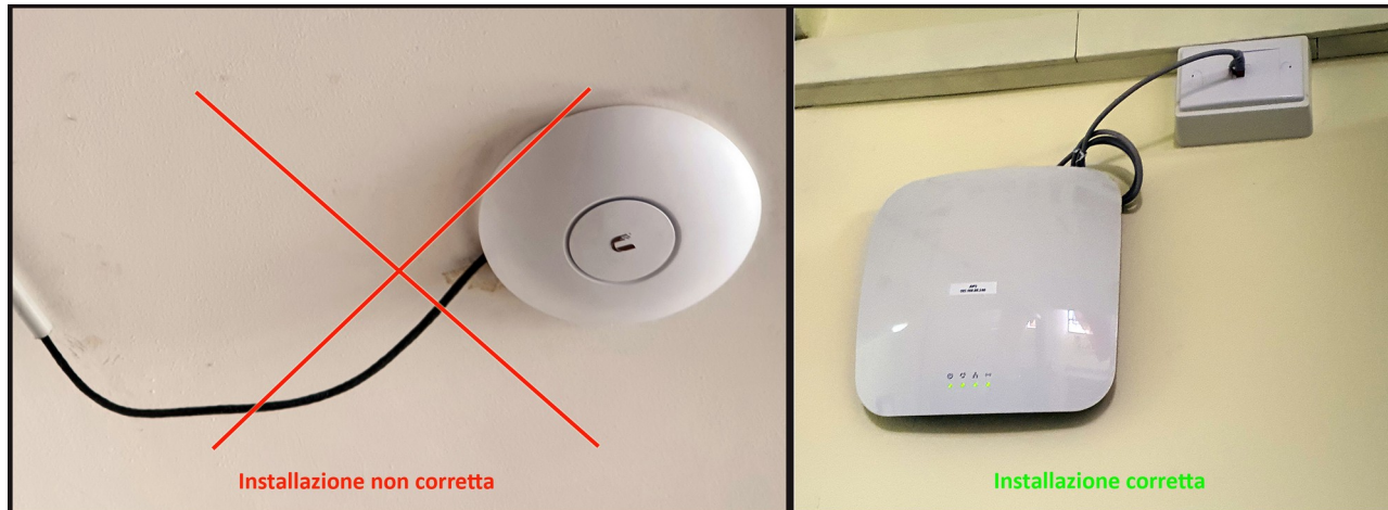
Figura 10 - Installazione corretta dell'Access Point
