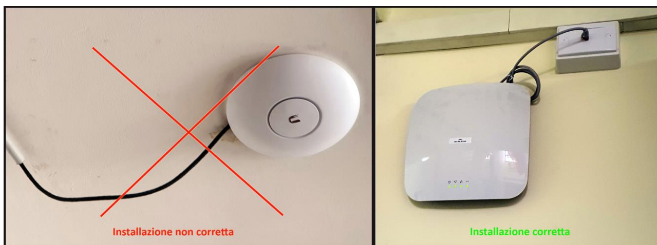
Figura 10 – Installazione corretta dell'Access Point
